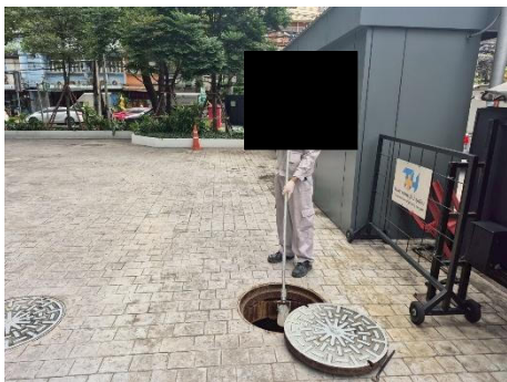
บ่อพักน้ำใสของระบบบำบัดน้ำเสีย
